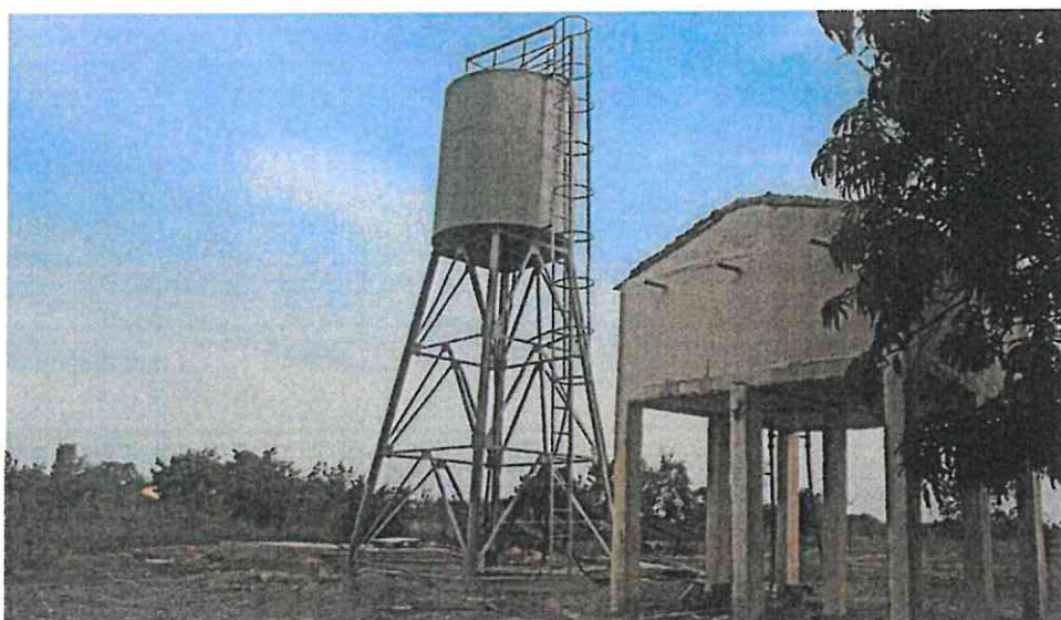
Création d'un réservoir pour l'alimentation du village
