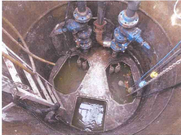
Poste de la route de Tours à Ecommoy
