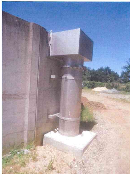
Figure 5 : Débitmètres d'entrée (à gauche) et caisson de surverse du bassin d'orage (à droite) à la station d'Ecommoy.
