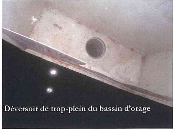
Sonde de surverse du bassin d'orage
