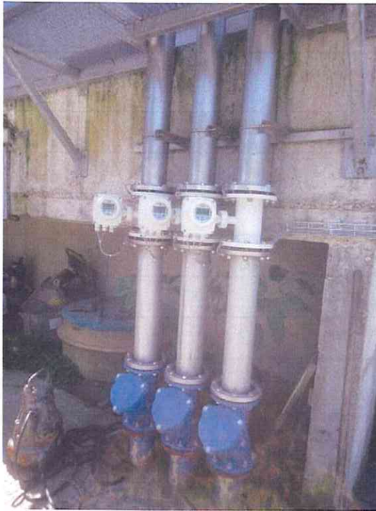
Figure 5 : Débitmètres d'entrée (à gauche) et caisson de surverse du bassin d'orage (à droite) à la station d'Ecommoy.
